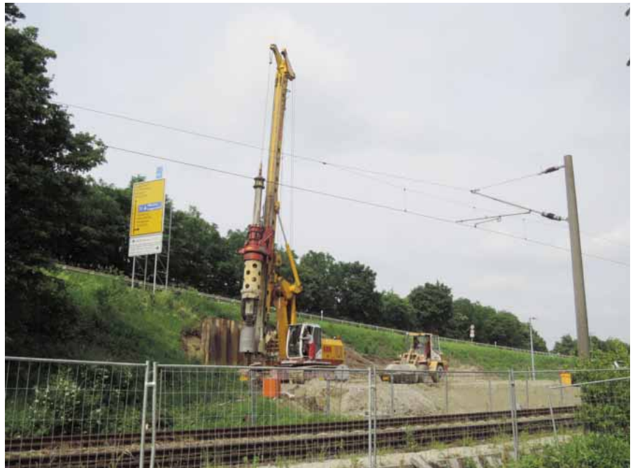
Freie Fahrt nach Höfen: momentan wird das Brückbauwerk erstellt
