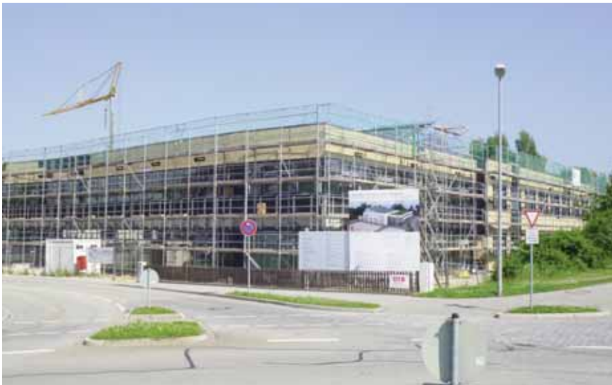
Blick auf die Fensterfronten aus Richtung Dr.-Josef-Hastreiter-Straße
