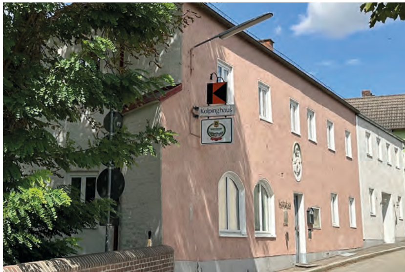
Das Kolpinghaus wurde über die vergangenen Jahre schrittweise saniert und ertüchtigt. Nun muss das Dach angegangen werden.
