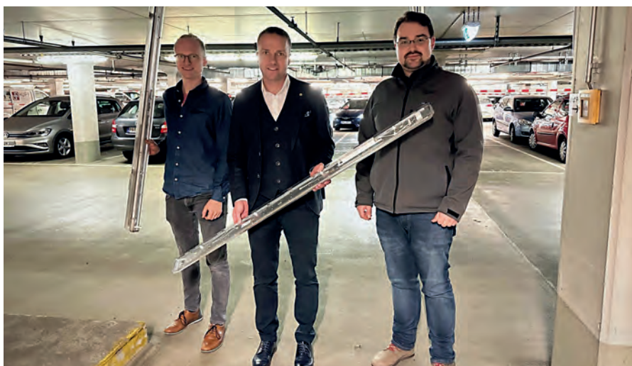
Klimaschutzmanager Tobias Bauer, Bürgermeister Armin Grassinger und Projektleiter Florian Hilpert aus dem Bauamt freuen sich über die neue, sparsame LED-Beleuchtung in der Tiefgarage Zentrum.
