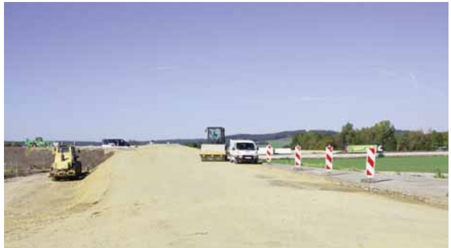
Bauarbeiten an der DGF 16
