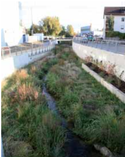
Reanturierung am Asenbach Nord
